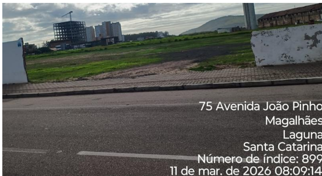
Figura 6: Vista da avenida, imagem externa abertura 01.
