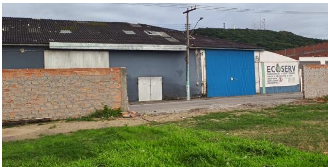
Figura 4: Retro área, imagem interna abertura 02.
