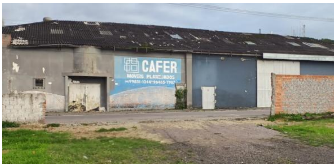
Figura 3: Retro área, imagem interna abertura 01.
